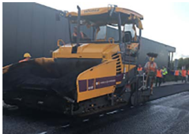
Aanleg van een lignine asfalt proefstrook
